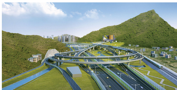
Fig. 1. Modificacions infraestructurals i industrials que modifiquen l'espai natural i el transformen en un espai urbà. Les infraestructures són un component clau en qualsevol entorn. Font: Investing Business Singapore
