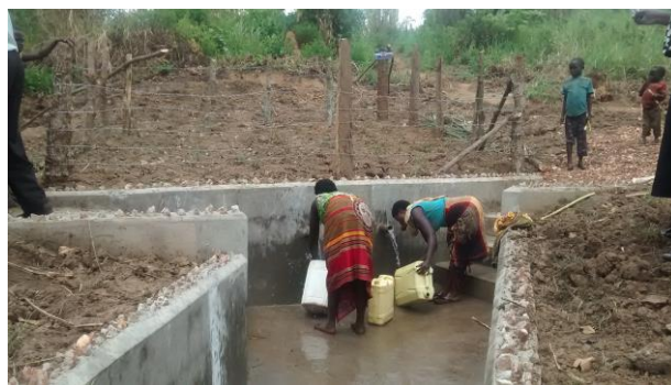
Figura 4. Fotografia del manantial després de la reparació Font: [20]
