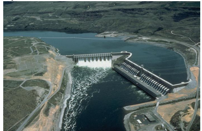
Il·lustració 1: La instal·lació hidroelèctrica a Chief Joseph Dam, Washington, que funciona sense grans reserves d'aigua
